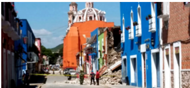
Edificio dañado por el el sismo del 19 de septiembre del 2017, en Atlixco, Puebla. Fuente: http://municipiospuebla.mx/nota/2017-09-19/atlixco/fallecen-3-menores-y-un-adulto-por-derrumbes-en-atlixco
