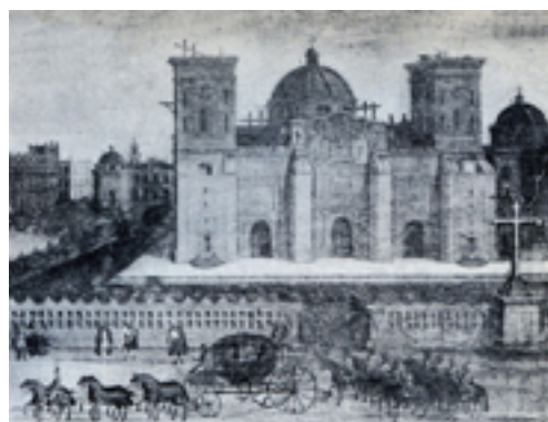
La Catedral Metropolitana en proceso de construcción todo el siglo XVIII. En parte, porque cuando la dañan los sismos, hay que reconstruirla. Fuente de la imagen: https://goo.gl/tBPh2S
