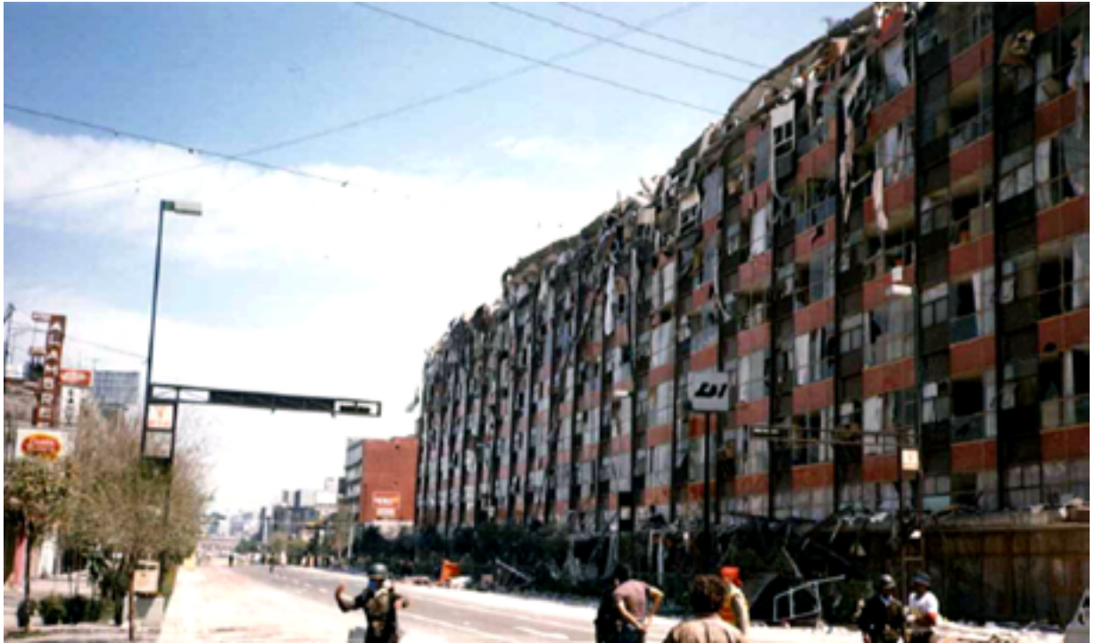
Edificios de 6 niveles o más afectados durante el sismo de 1985
