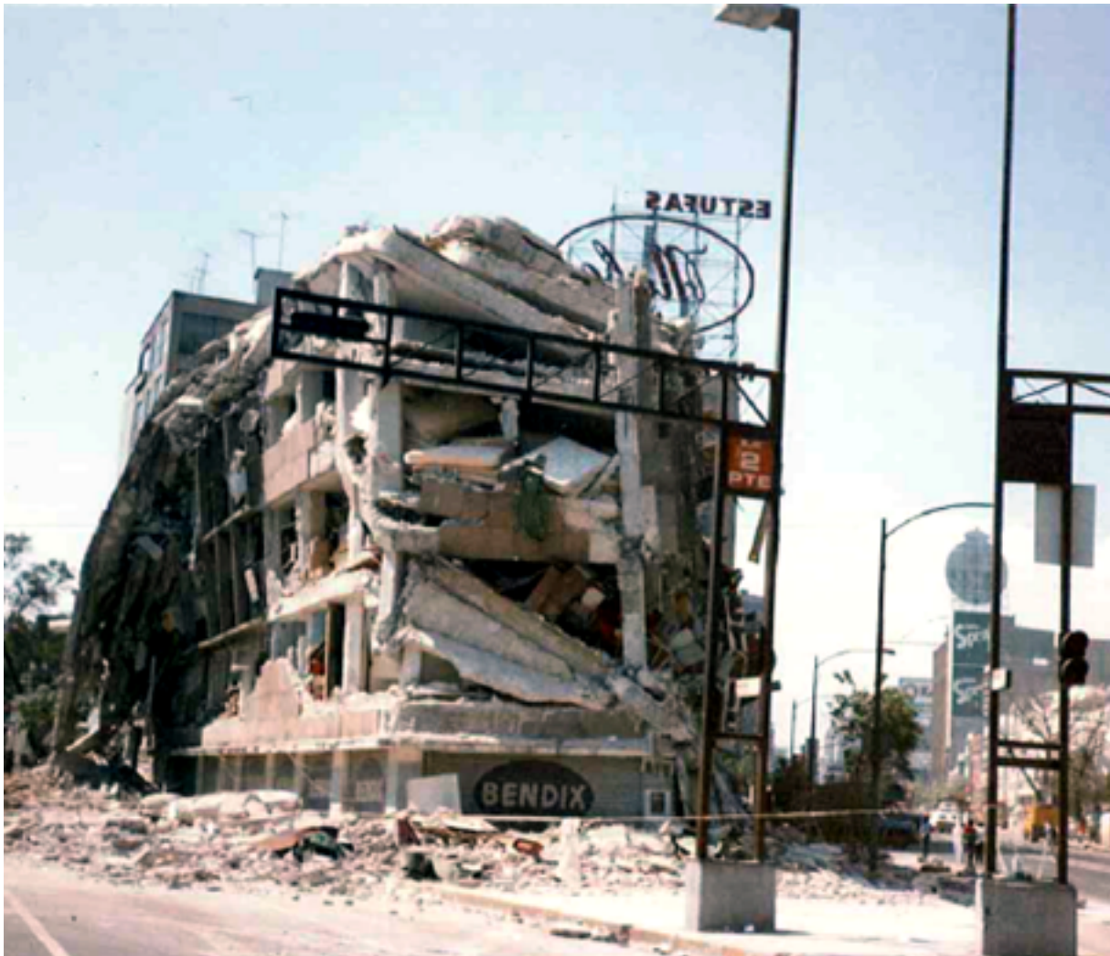
Edificio afectado durante el sismo de 1985 Fuente: Fotos compartidas por los miembros del comité y grupos de trabajo daños AMIS
