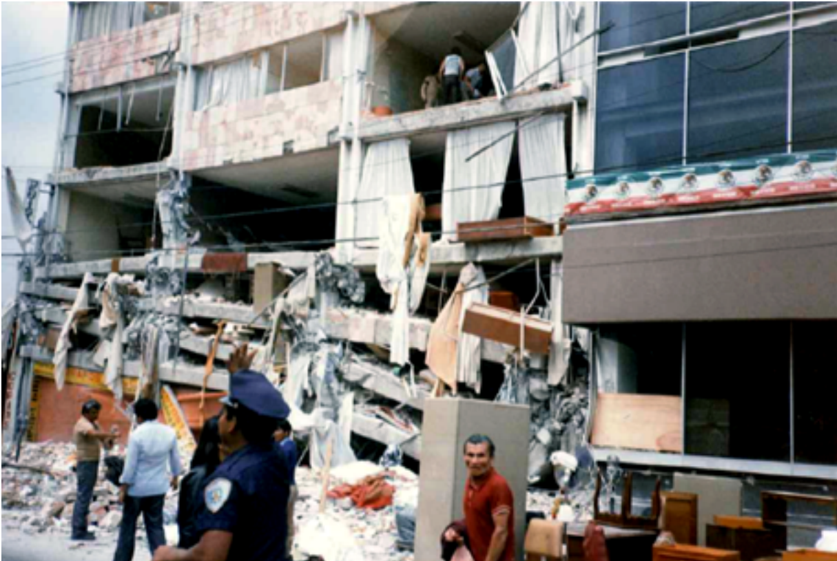
Edificio dañado por el sismo de 1985
