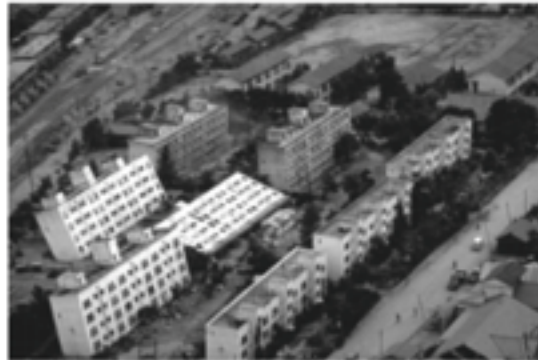
Figura 1.4 - Edificios inclinados por licuación de arenas
