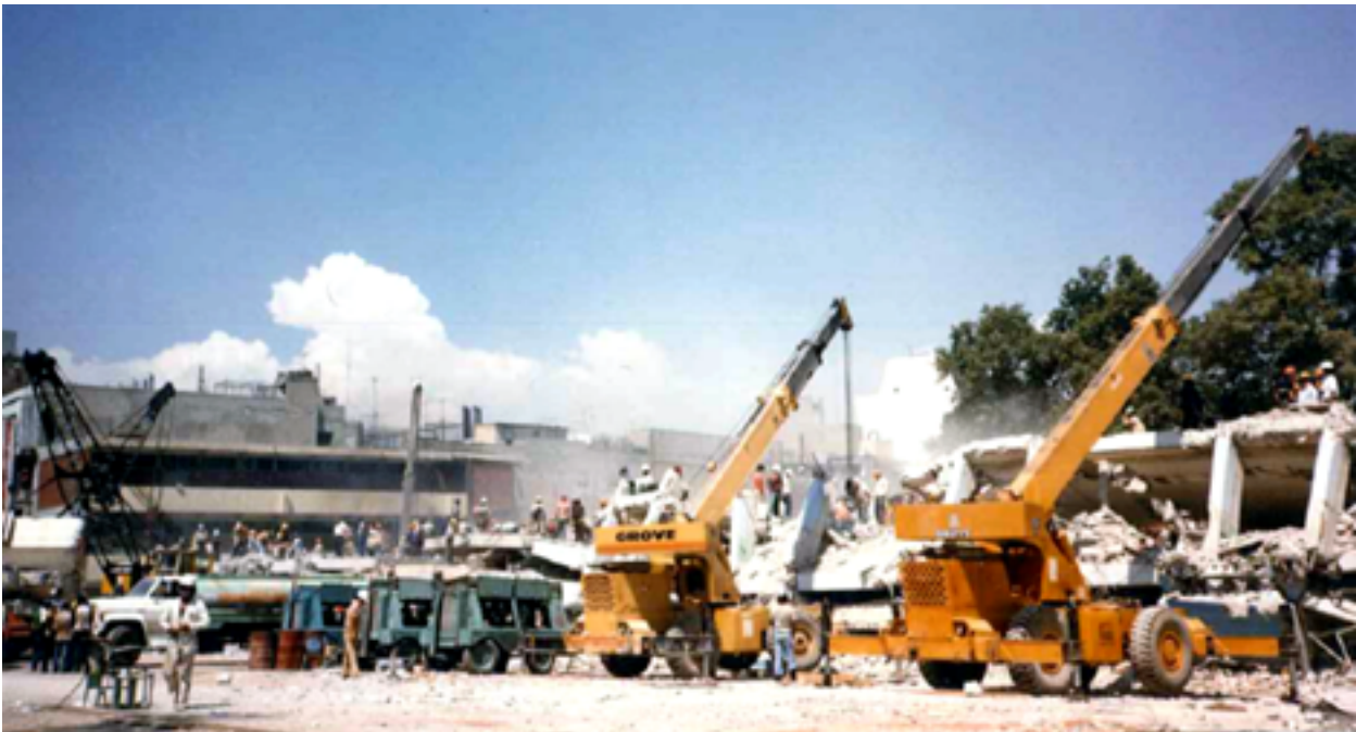
Trabajos de remoción de escombros de edificios afectados por el sismo de 1985
