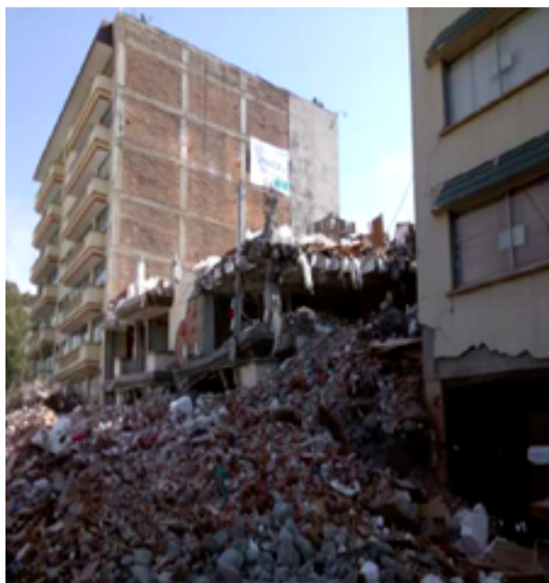
Condominio derrumbado por el sismo del 19 de septiembre, colonia Lindavista, Ciudad de México. Fuente: Fotos compartidas por grupos de trabajo de la AMIS
